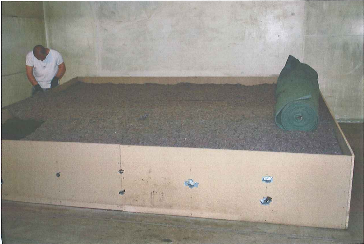
Bild 3. Vorbereitung der Auslage des Geotextils.
