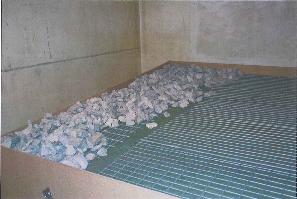
Bild 4 Stahlgittermatte und Steineschicht
